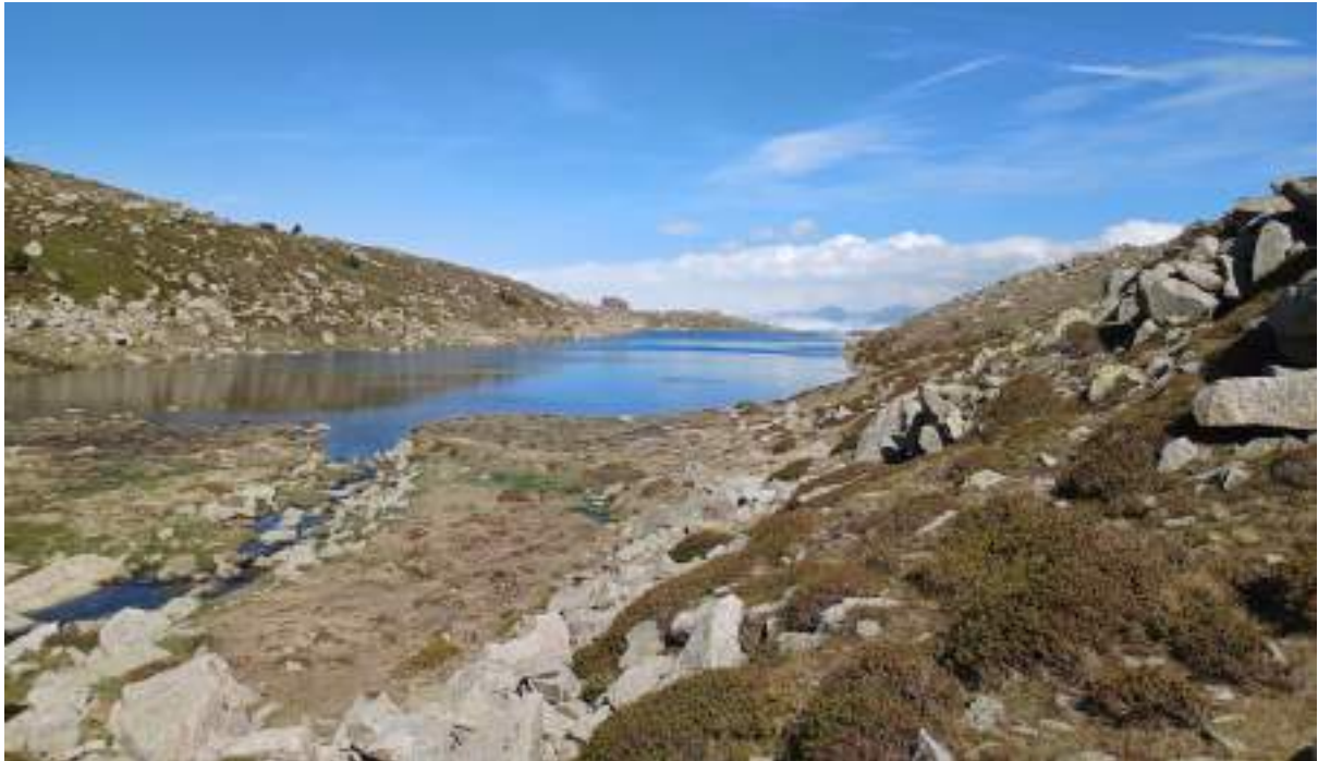
Etang du Coll Roig, déversoir en balcon sur la vallée, cabane (maison) à droite au fond
